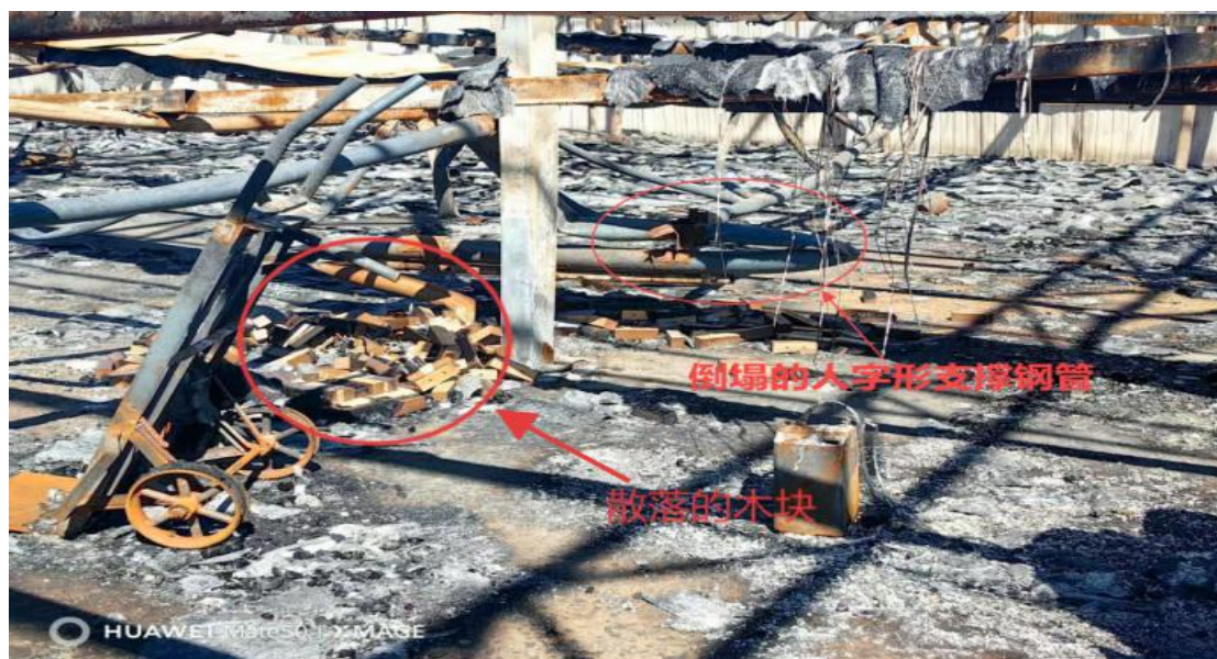
人字形支撑钢管和散落的木块
