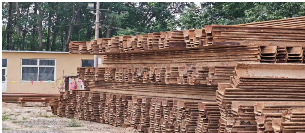
图2 场内钢板桩存放图
